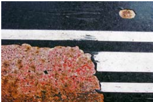
ULRIKE JAKUBEK GEFÄHRDETE ORTE: DAS NORDBAHNHOF-AREAL
